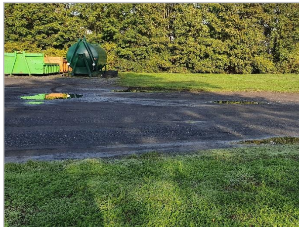
Photo 6 : Surfaces artificialisées, © Rainette, 2022
